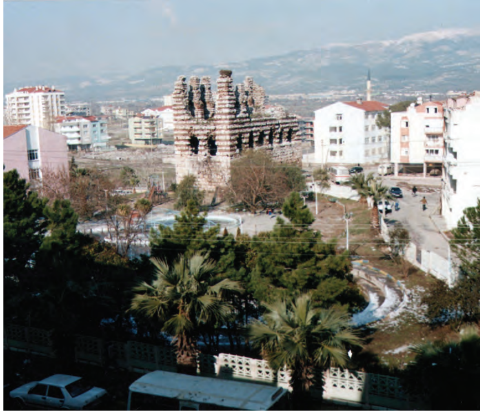
Resim 2 Eylül 2002'de kazı başlamadan önce saraya güneydoğudan bir bakış: Çalışmalarda resmin sağ alt köşesindeki amfi basamakları kaldırılmış, yapıya yakın havuz kısmen sökülmüştür.
